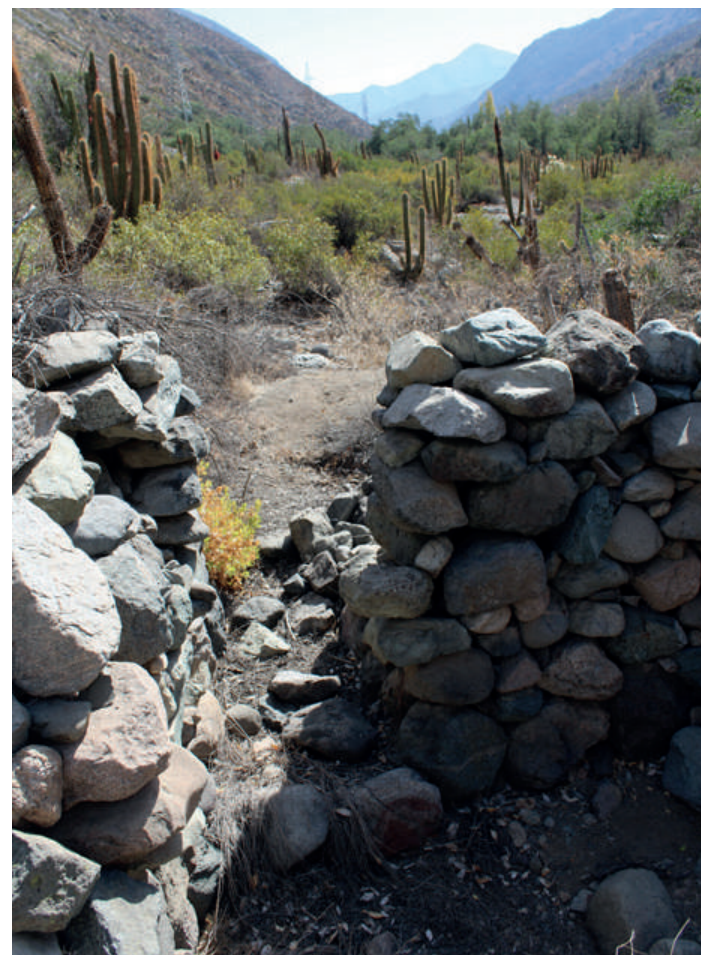
Imagen 13: Vista de entrada a uno de los recintos con desnivel (escalón).
