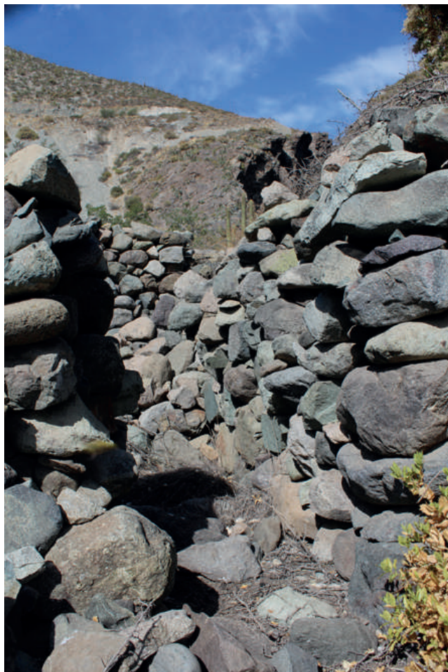
Imagen 12: Vista de vano de entrada a uno de los recintos.
